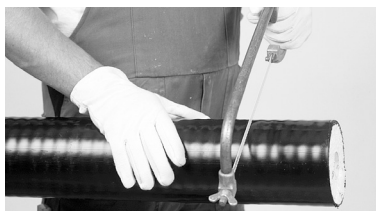
2 Kapa kulverten vinkelrätt med t ex metallsåg.
