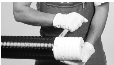
5 Ta bort isolering och eventuella rester längs
