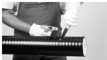
3 Skär upp ytttermanteln med en kniv.. Obs: Skada ej mediaröret!
