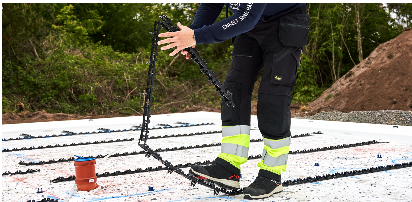
VVS-montøren vikler ut og legger ned skinnen på EPS-isoleringen.
