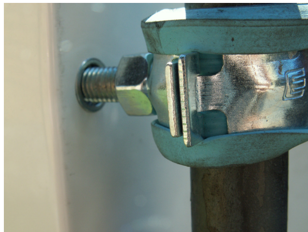
Nærbilde av innfesting mot skap
